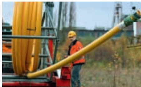
Bisher bestanden Gasleitungen aus Stahl, jetzt können flexible, aber nicht weniger stabile Rohre aus VESTAMID verlegt werden
